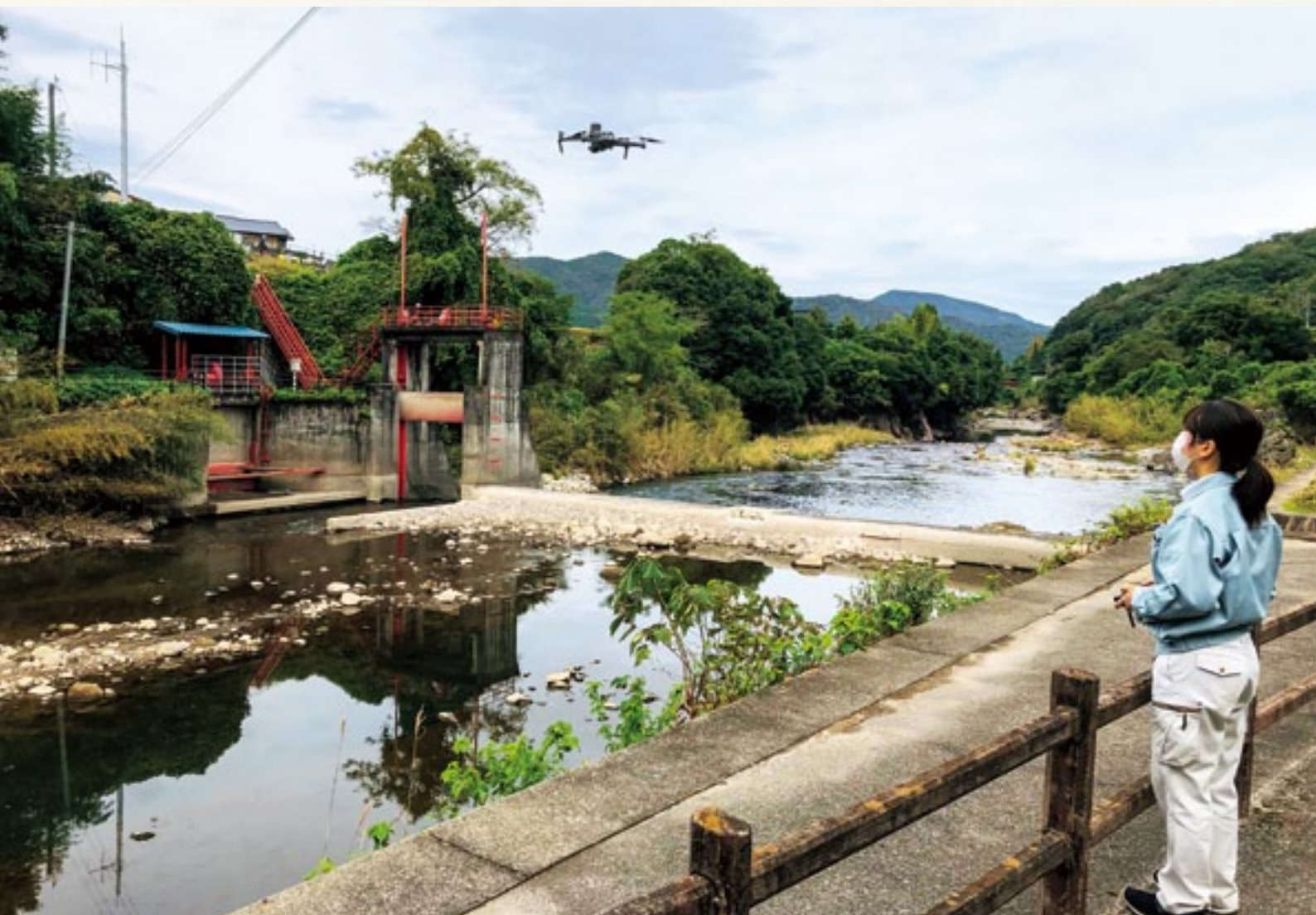
UAVを用いた土地改良施設の日常点検実証調査（駅館川地区）
