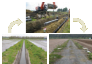
用水路のパイプライン化と農道の拡幅
