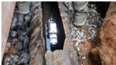
管内カメラによる調査状況
