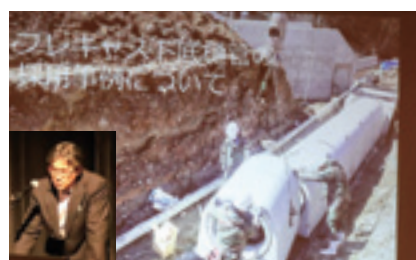
【プレキャスト底樋管の採用事例について】 大分県西部振興局 農林基盤部 農村整備班 野上 康則
