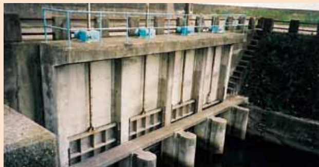
第1号樋門前面（平成5年10月撮影）
