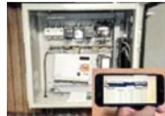
監視装置の設置
